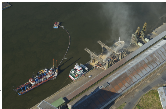
Dragage sur le site portuaire nantais de Roche-Maurice/France
