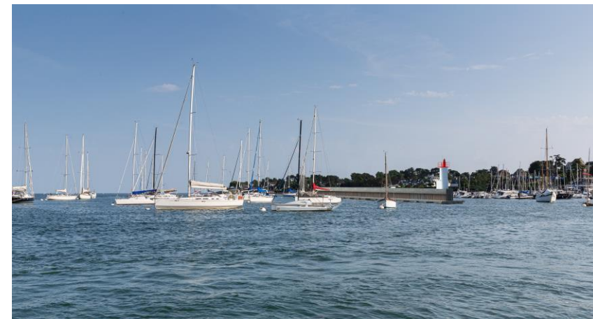
Extension du môle Tabarly – Port de La Trinité-sur-Mer
