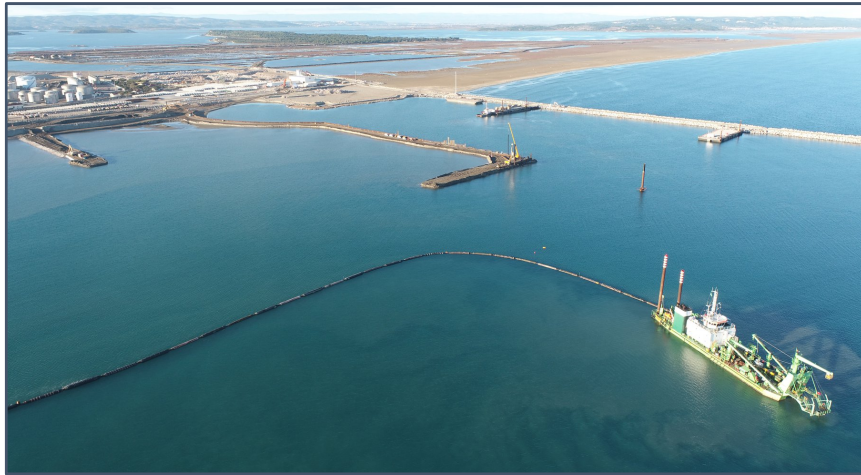
Construction des merlons d'enclosures Novembre 2022
