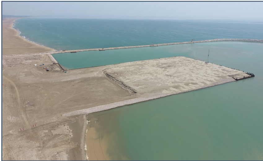
Remblaiement et surcharge du Môle Marchandises Mai 2023
