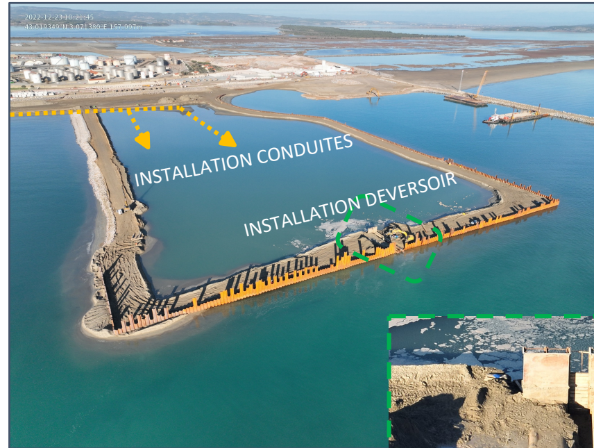
Phase remblaiement Môle Marchandises Décembre 2022
