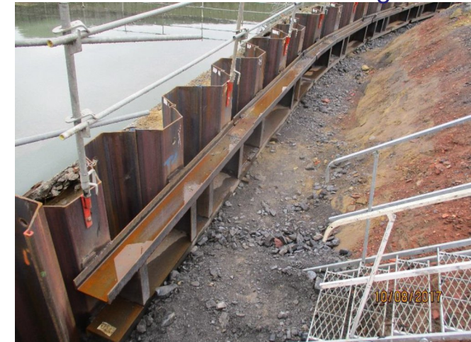
Mise en place de la lierne métallique à l'arrière des palplanches
