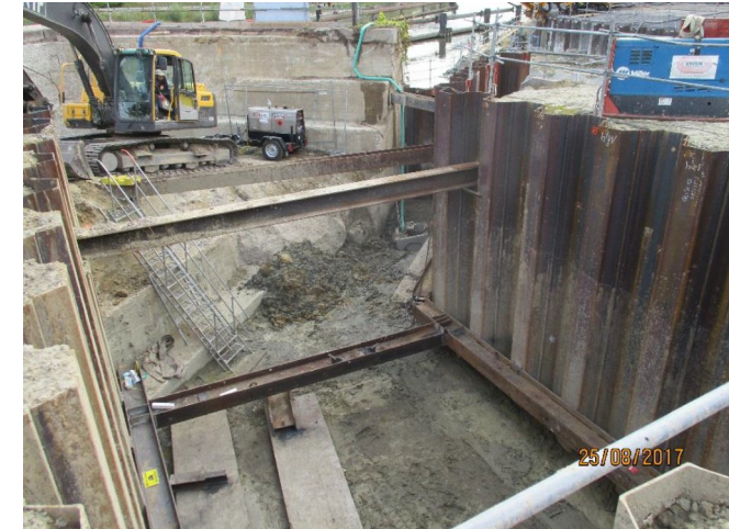
Terrassement et butonnage
