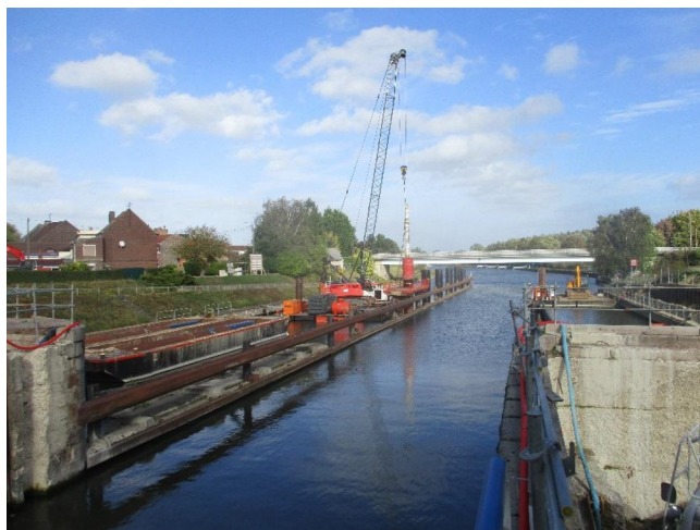
Battage des nouveaux tubes
