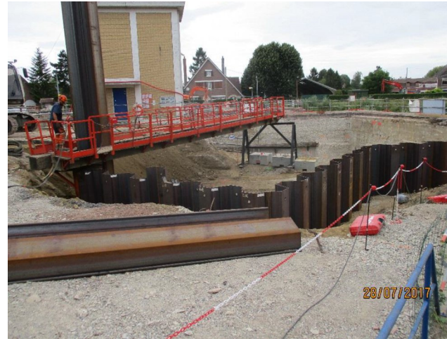
Mise en place des palplanches
