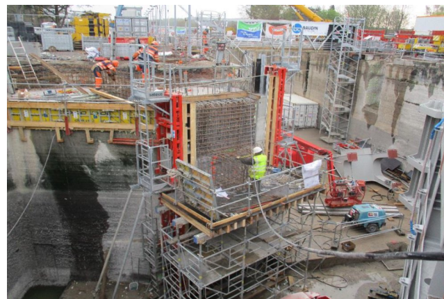
Ferrailage de la console
