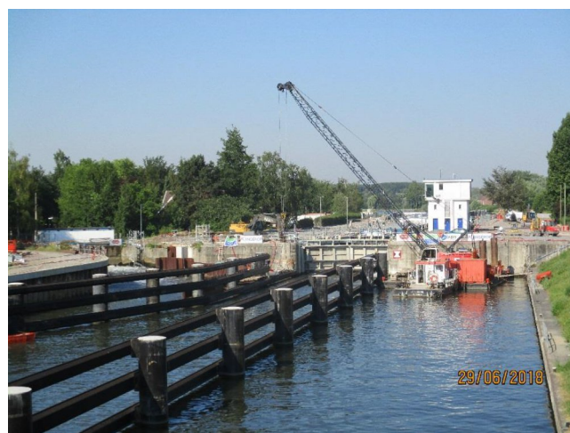
Mise en place des nouvelles lisses
