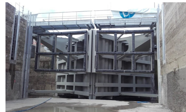
Vantaux amont avant la remise en eau
