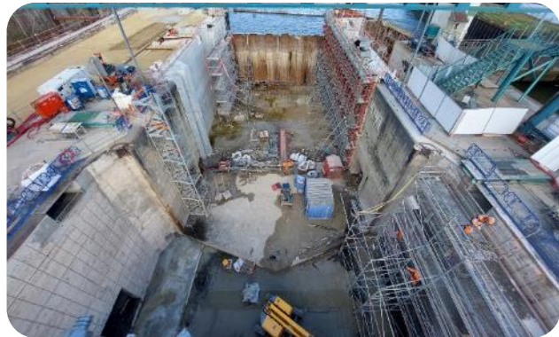
Bétonnage nouveaux bajoyers
