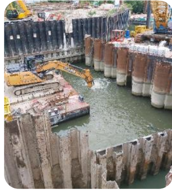
Démolition aval radier
