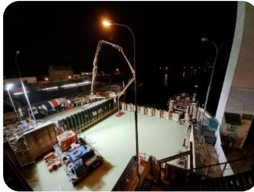
Bétonnage bouchon béton immergé
