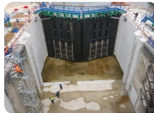
Pose nouvelle porte
