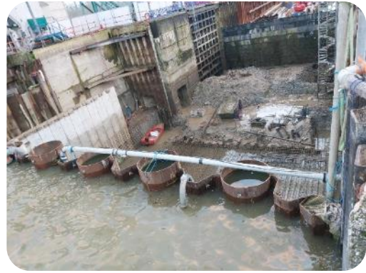
Batardeau aval en Combiwall
