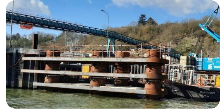
Nouvel ouvrage de guidage aval
